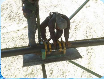
Welding PE Pipe 5"
